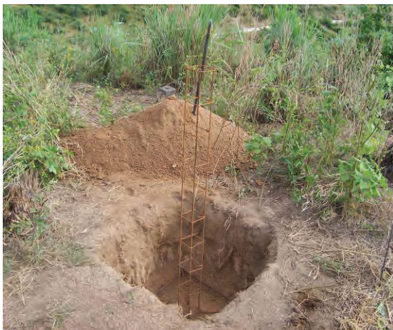
Figura 3. Construcción de la base geodésica de apoyo (estación CERR).
